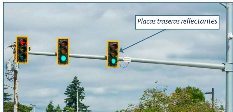
Arriba: Las mejoras de seguridad incluyen la instalación de placas traseras reflectantes para los cabezales de los semáforos.
